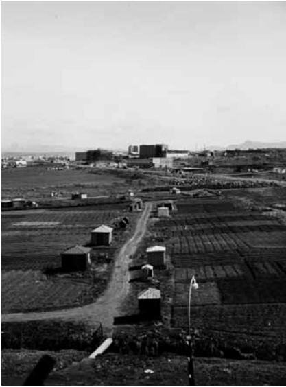
Horft austur Suðurlandsbraut.
